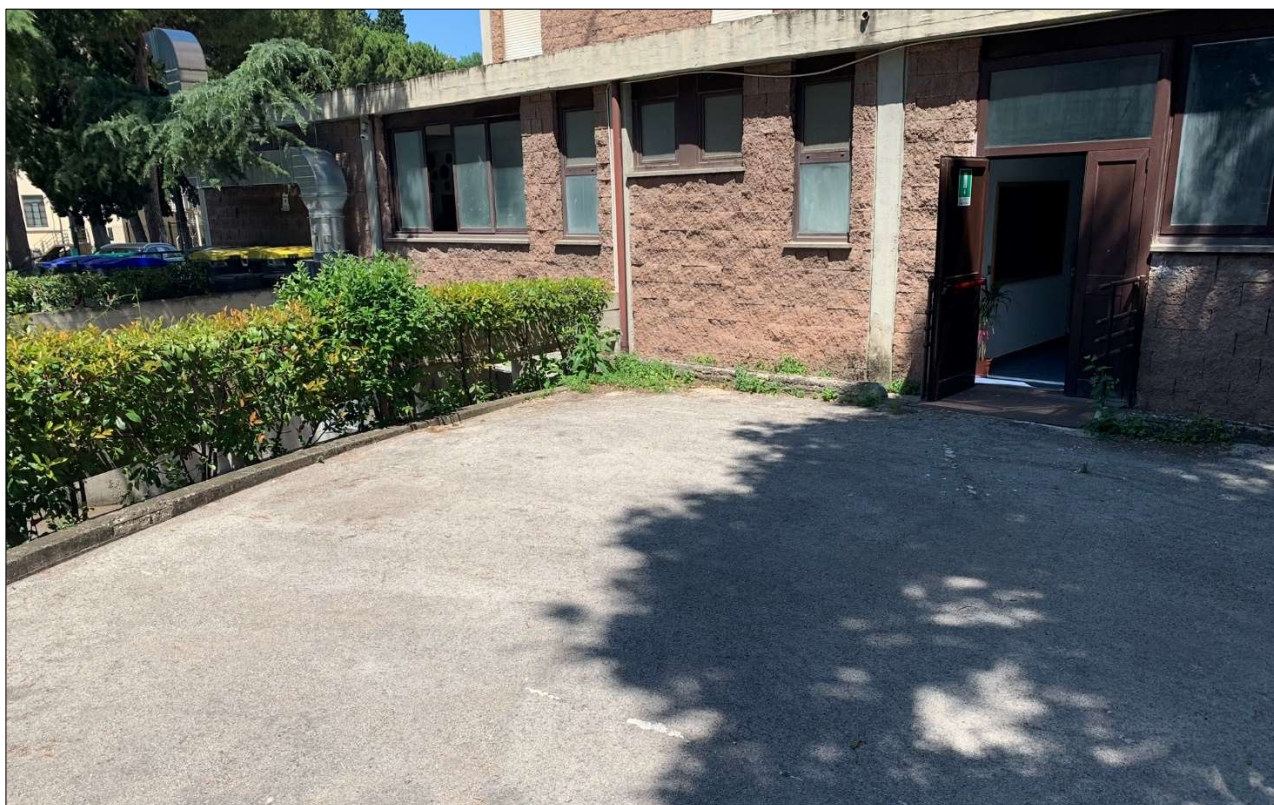
Foto. La vista dell'uscita secondaria retrostante (via di esodo)
